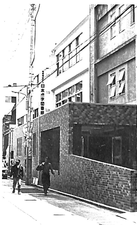
日本点字図書館新館一部完成（3月）。 来年3月には4階まで完成予定。
