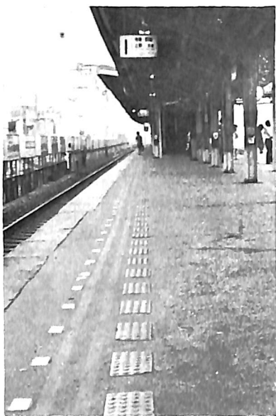
駅のホームの点字Dタイル。
